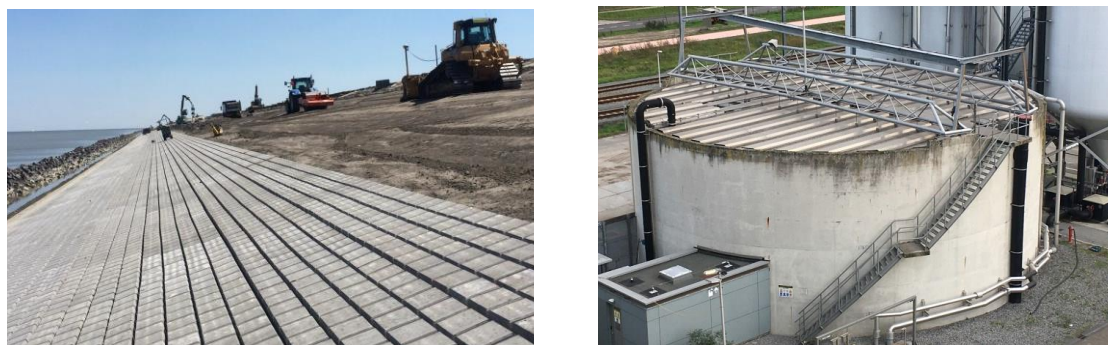
Figuur 3 - Dijkversterking Lauwersmeerdijk (links) en afdekking slibbuffer (rechts)
