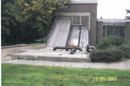
Vijzelgemaal rioolwaterzuivering
